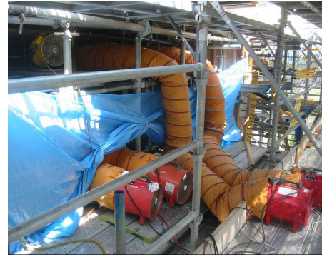
写真-1 エアクーリング実施状況
