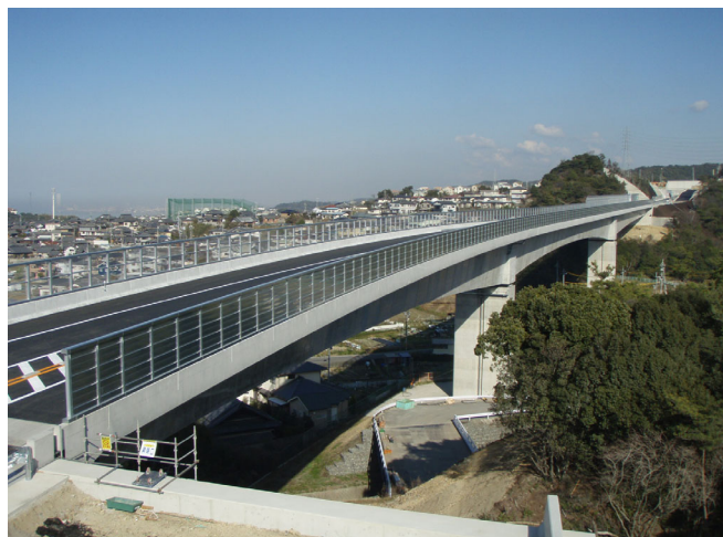
写真-4 完成写真
