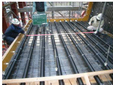
写真-3 下床版シース配置状況
