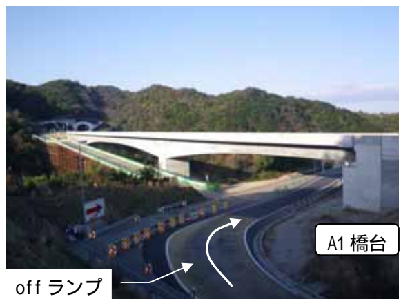
写真 - 2 完成時全景
