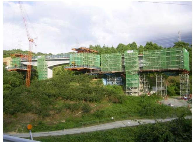
写真-1 施工状況
