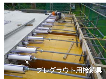
写真-7 接続具使用状況
