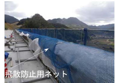
写真-5 壁高欄コンクリート打設後の養生
