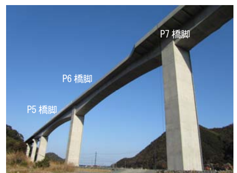
写真-9 全景写真
