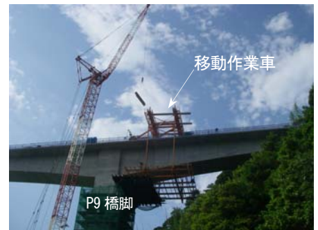
写真-8 移動作業車解体状況 (P9橋脚)
