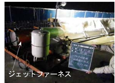
写真-6 壁高欄コンクリート打設後の給熱養生
