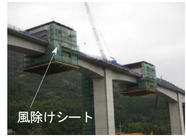
写真-4 移動作業車の寒中養生
