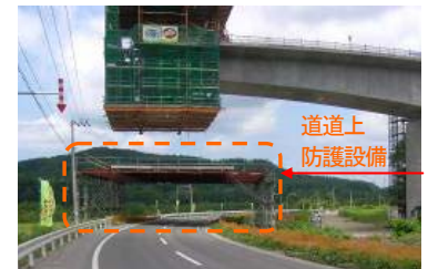
写真-2 桁下防護状況
