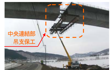
写真-3 吊支保工組立状況
