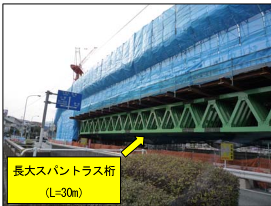
写真-6 長大スパントラス桁
