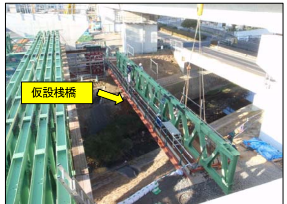
写真-7 仮設栈橋
