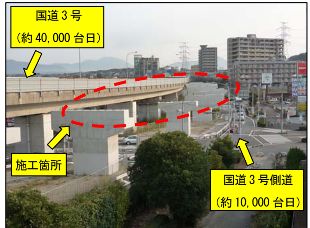
写真-1 施工箇所全景
