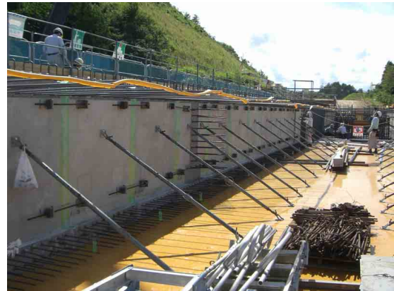
写真－2. プレテンションウェブ設置完了
