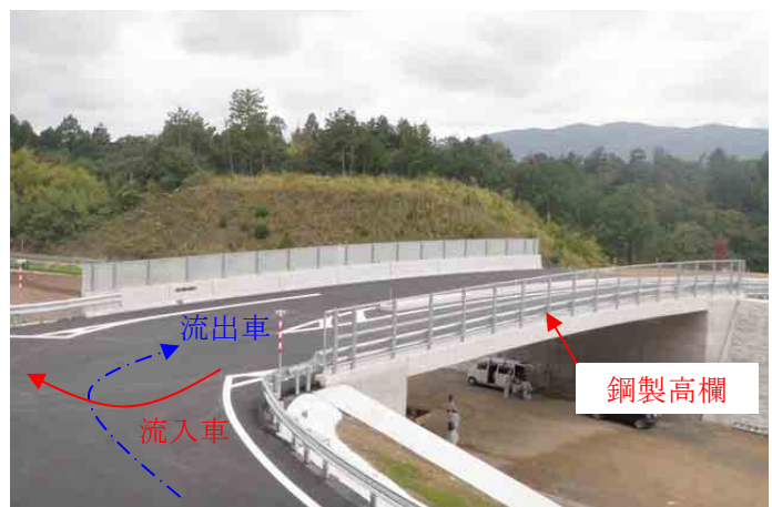
写真－3. 鋼製高欄設置状況
