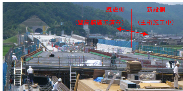
写真-1. 主桁と壁高欄の施工状況
