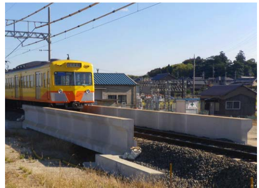
写真-1 完成桥梁全景(河川切替前)
