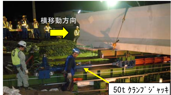
写真-3 桁横取り架設状況
