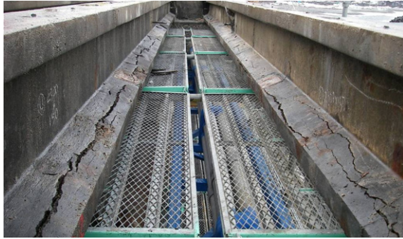
図-1 解体・撤去時の鱗崎橋の外観
