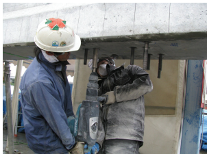
図-5 アンカー施工状況
