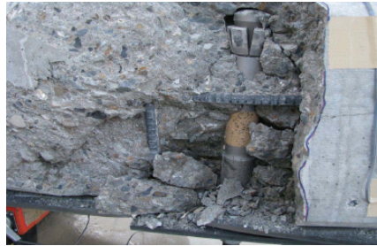
図-15 アンカー埋込み状況
