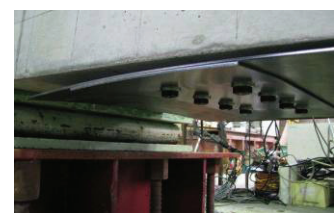
図-3 アンカー取付状況
