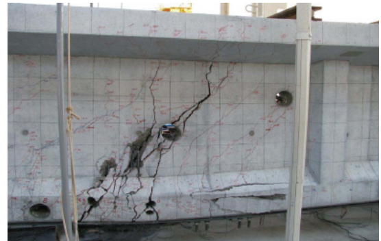
図-13 最終サイクル載荷時 (実大試験体)
