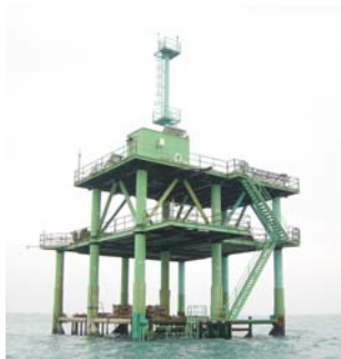
写真-1 海洋技術総合研究施設
