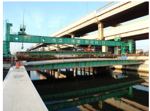
写真-5 主桁架設状況
