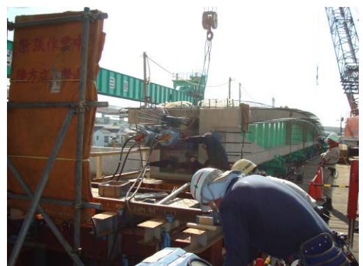
写真-3 緊張状況
