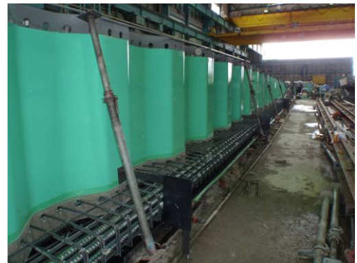
写真-2 主桁製作状況
