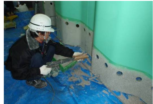
写真-1 珪砂塗布状況
