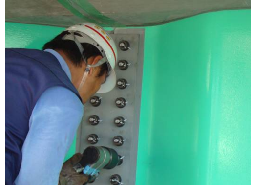
写真-4 ボルト接合状況
