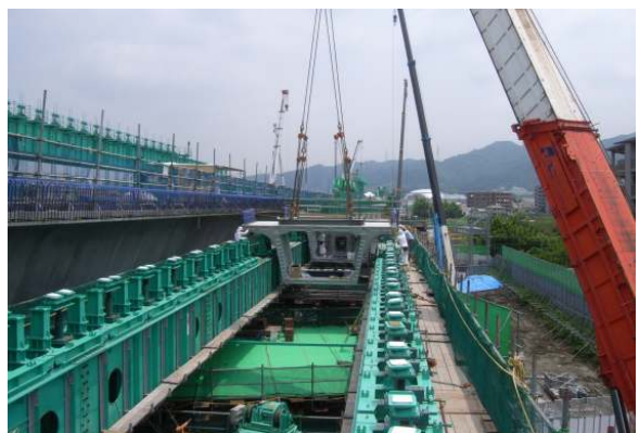
写真－2 スパンバイスパン架設工法 （サポート式架設）
