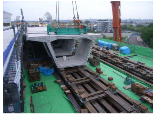
写真－3 固定支保工による架設
