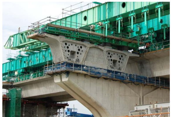
写真－4 柱頭部セグメント横桁先行連結
