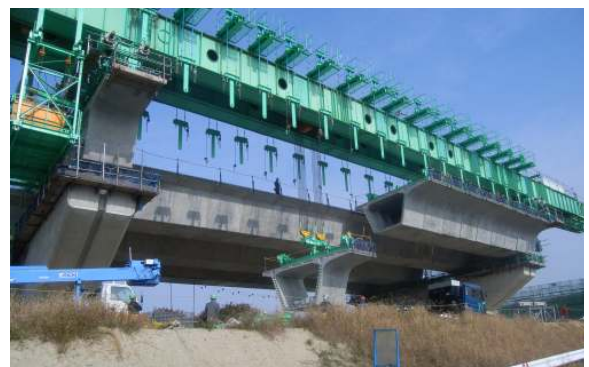
写真－1 スパンバイスパン架設工法 （ハンガー式架設）
