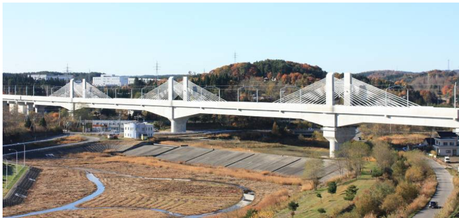
写真-1 三内丸山架道橋
