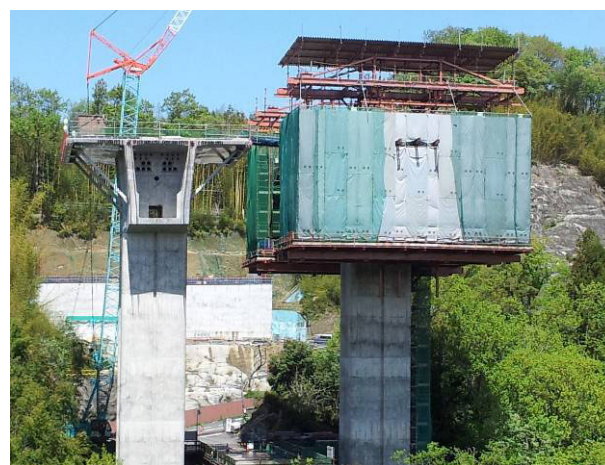
写真-2 P1 上下線施工状況
