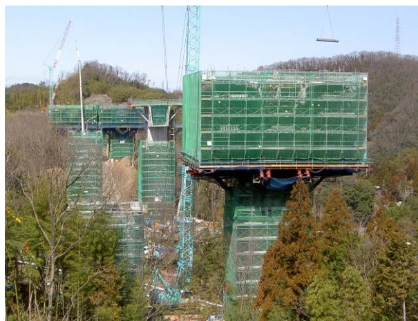
写真-3 P4~P6 施工状況
