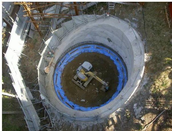
写真-1 竹割り型土留め工施工完了
