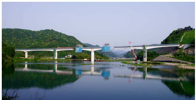
写真-1. 施工状況（左側面より望む）
