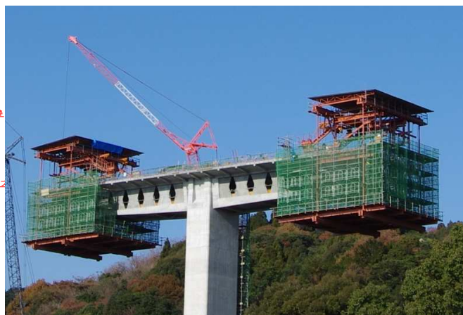
写真-2 張出し架設状況
