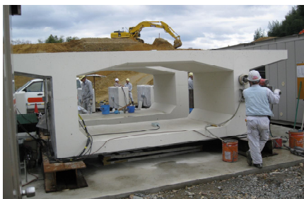
写真-1 実物大供試体の外観
