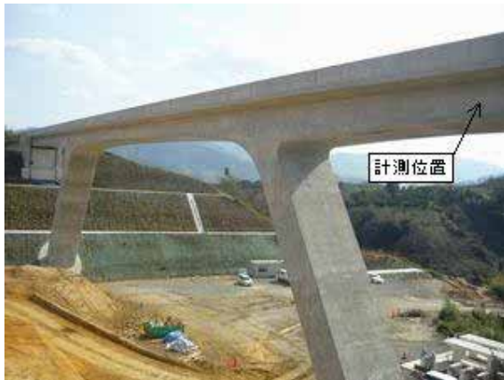
写真-1 実橋のひずみ計測位置
