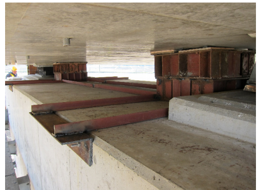
写真-2 仮受け架台
