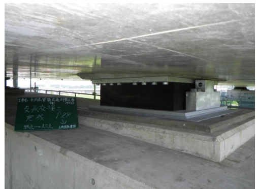
写真-6 支承取替完了
