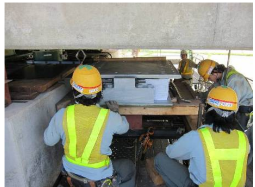
写真-5 支承取替状況
