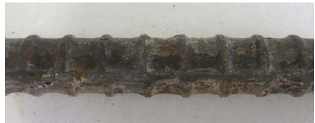
写真-2 脱塩1年後の鉄筋状態
