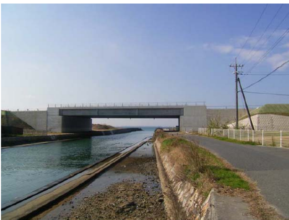
写真-5 梶栗川橋
