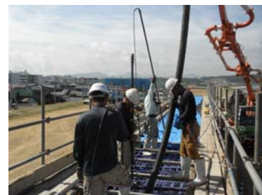
写真-3 長尺棒状バイブレータ
