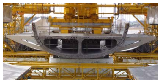
写真-1 主桁断面
