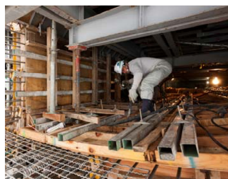
写真-3 打設状況
