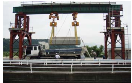
写真-4 仮門構・運搬状況
