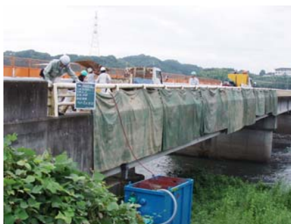
写真-2 養生状況全景
