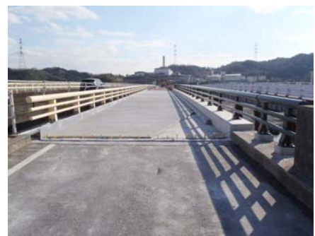
写真-5 完成写真
