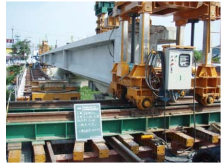
写真-3 吊上げ状況
