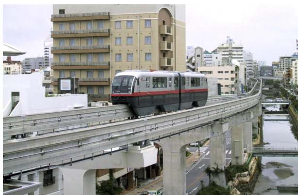
写真-1 跨座型モノレール
