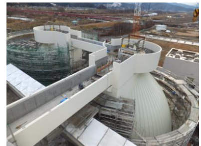
写真-10 頂部施工状況
