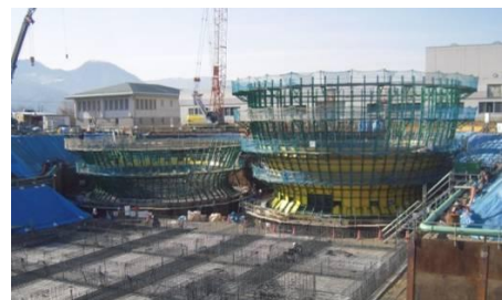
写真-5 赤道以下施工状況
