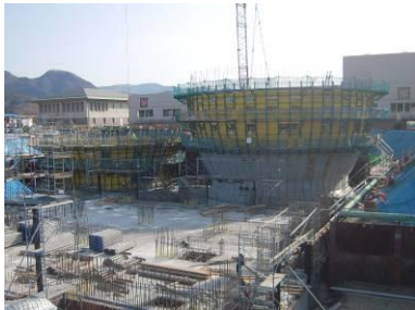
写真-7 赤道以下施工状況
