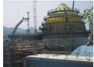
写真-9 型枠組立完了
