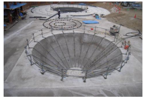
写真-3 下部円錐部施工状況
