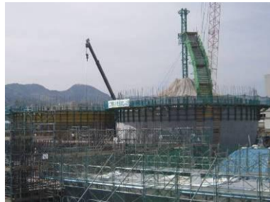
写真-8 回転足場架設
