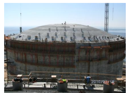
写真-17 屋根ドーム完成状況
