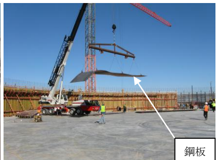
写真-7 鋼板敷設状況
