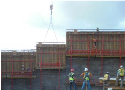
写真-8 型枠設置状況
