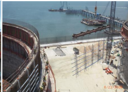
写真-9 側壁シース吊込み状況
