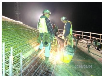
写真-16 夜作業状況
