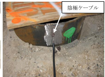
写真-4 電気防食施工状況
