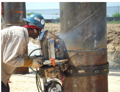
写真-2 杭接合部溶接状況
