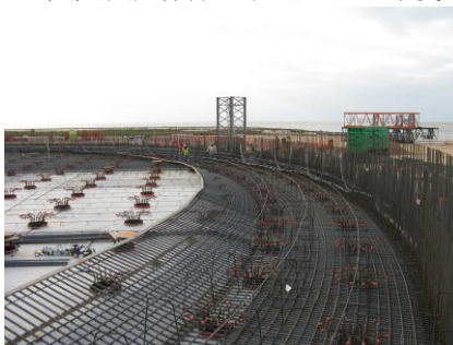
写真-5 底版鉄筋配置状況
