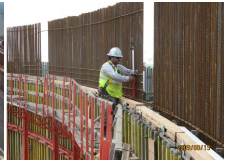
写真-10 型枠位置計測状況
