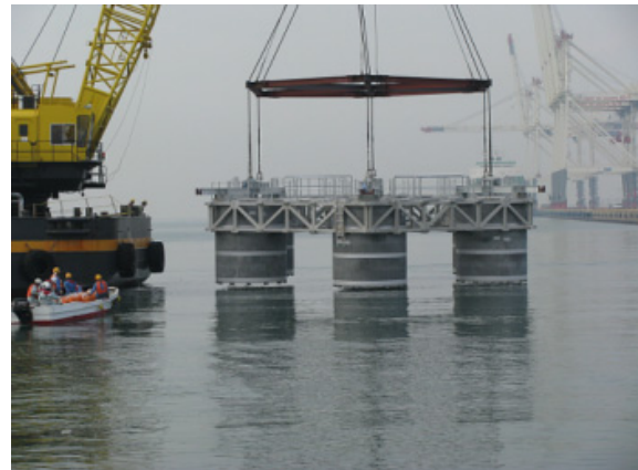
写真-2 試験施設進水状況
