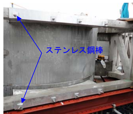
写真-1 円筒浮体・連結材接合部
