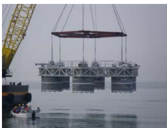
写真-11 進水状況
