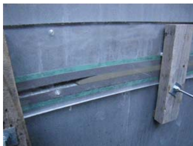
写真-6 目地充填状況
