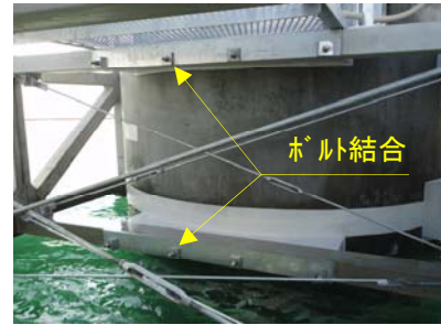
写真-10 ボルト結合部
