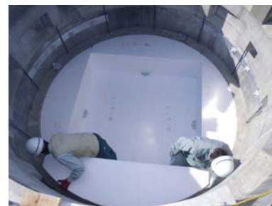
写真-7 内部充填状況
