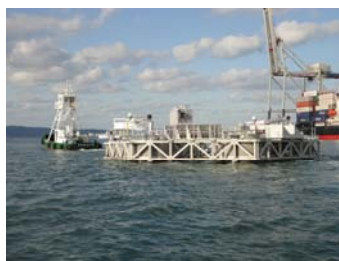
写真-12 曳航状況
