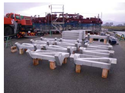
写真-4 トラス部材
