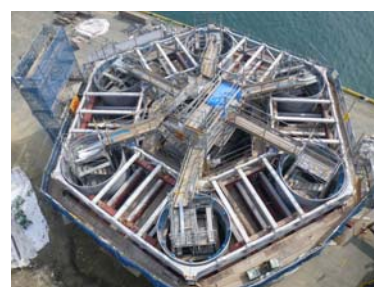
写真-8 組立状況
