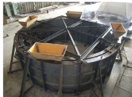
写真-3 型枠組立状況
