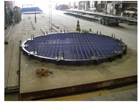
写真-1 底版配筋状況
