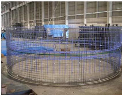
写真-2 配筋状況
