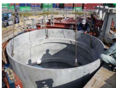
写真-5 円筒組立状況
