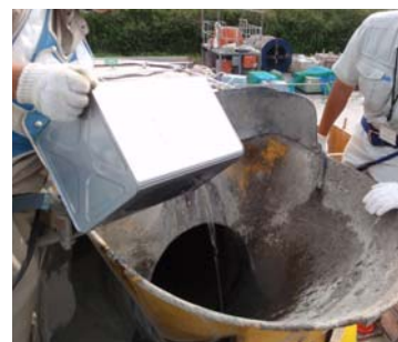
写真-1 収縮低減剤添加状況
