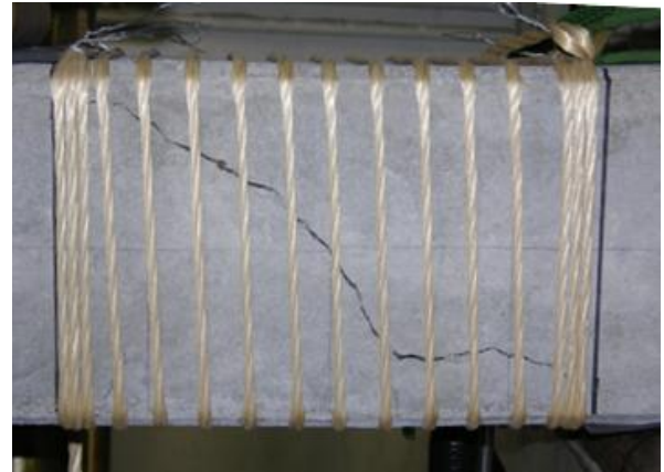
写真-4 斜めひび割れ状況 (No. 6)
