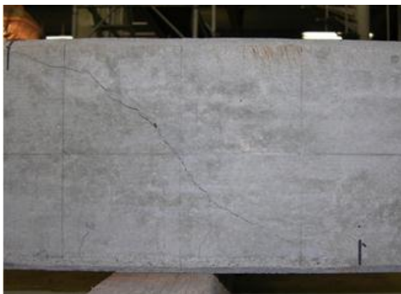
写真-1 斜めひび割れ状況 (No. 1)
