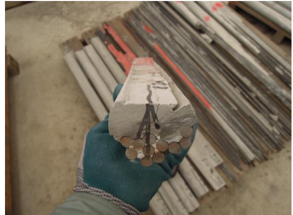
写真-4 PC グラウト充填度の解体調査
