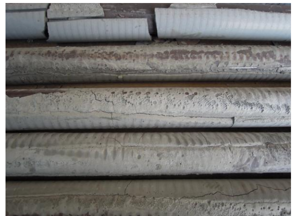
写真-5 PC 鋼棒一般部の充填状況
