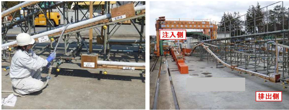
写真-1 注入状況および実物大試験体全景
