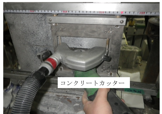
写真-3 スリット切削状況
