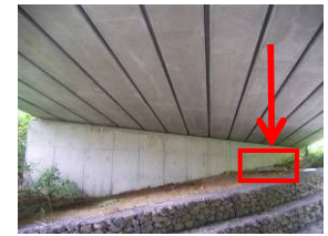
写真-2 俵山4号橋
