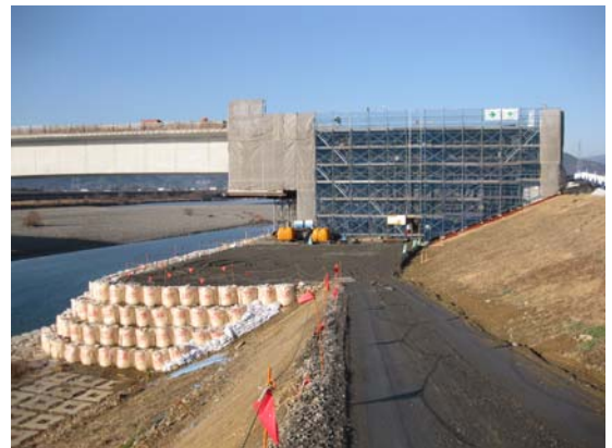
写真-3 A1 側径間施工ヤード
