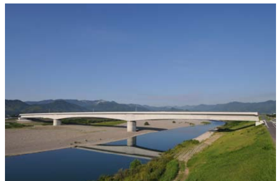
写真-4 完成写真
