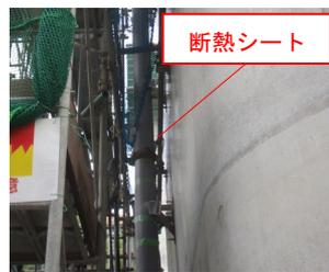
写真-2 鉛直配管養生
