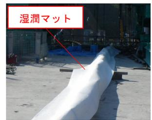
写真-3 水平配管養生
