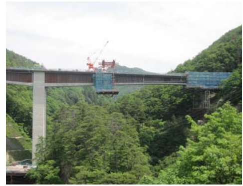
写真-2 移動作業車によるたわみ調整
