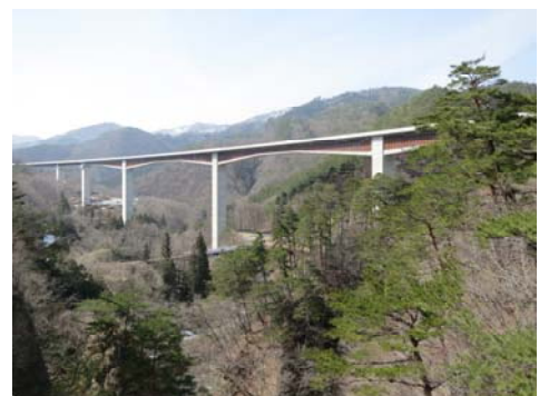
写真-3 完成全景
