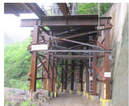
写真-1 門型構造支保工
