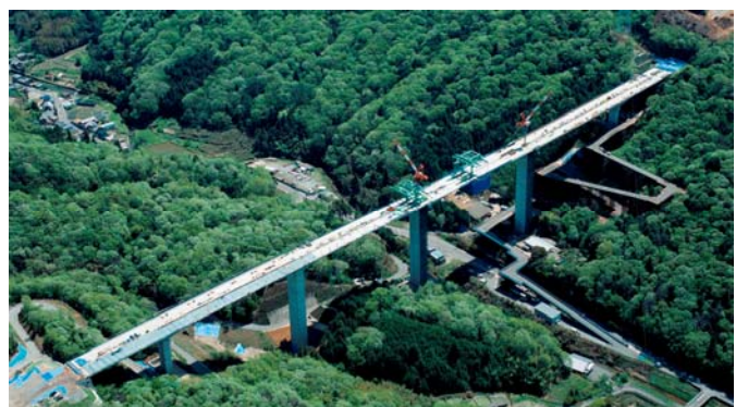
写真-5 平成24年5月施工状況全景
