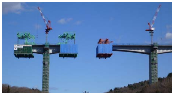
写真-2 張出架設の状況
