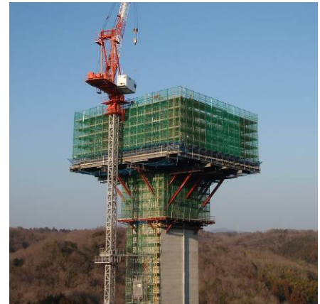
写真-3 柱頭部施工状況
