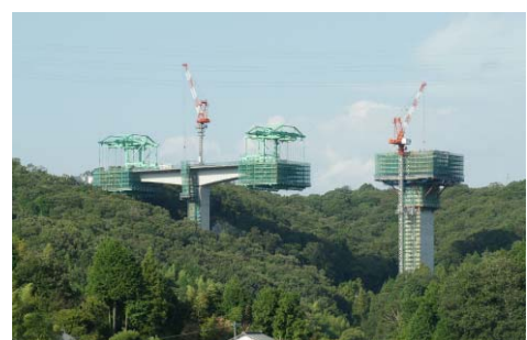
写真-1 施工状況 (全体)
