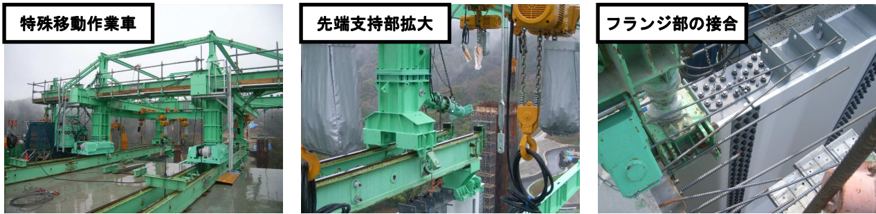
写真-3 特殊移動作業車および波形鋼板フランジ部の接合
