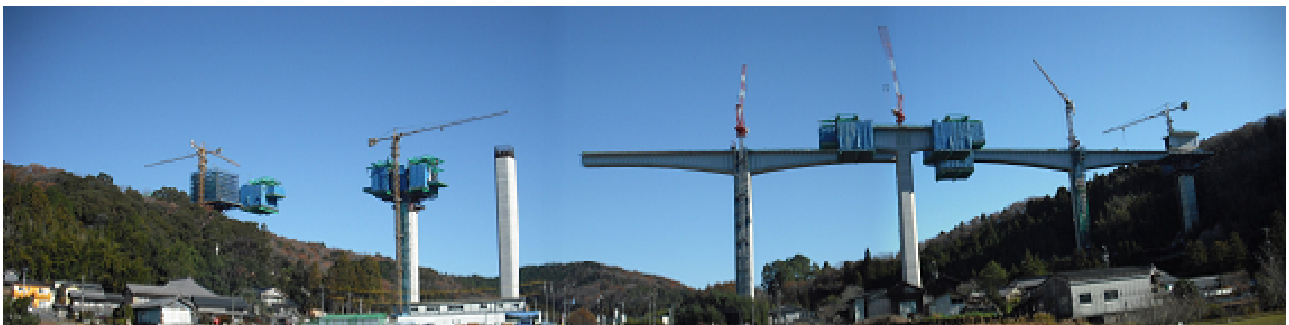
写真-5 施工時のクレーン配置
