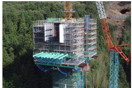
写真-4 柱頭部施工
