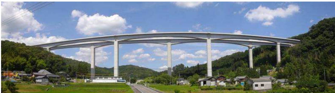
写真－6 橋梁全景
