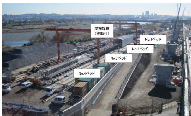
写真－3 製作ヤード全景
