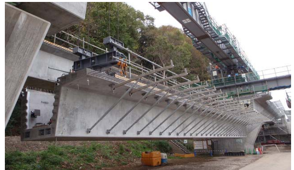
写真-1 U桁リフティング架設
