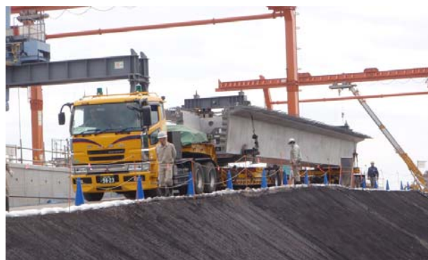
写真－4 U桁運搬
