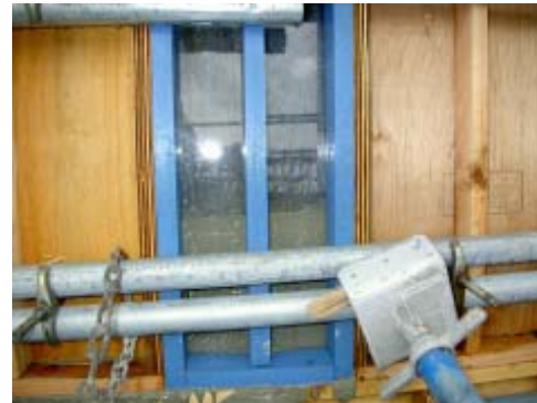
写真-1 ウェブコンクリート充填状況
