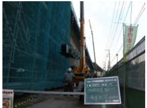
写真-3 クレーン作業状況
