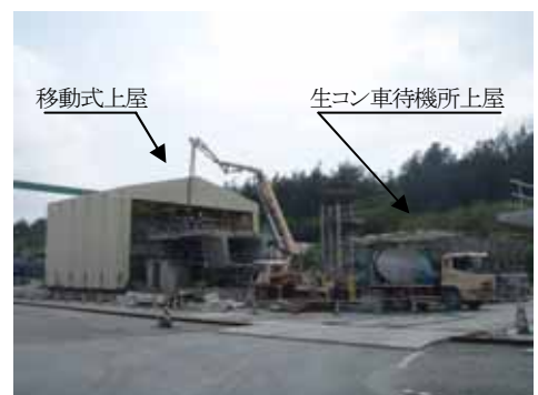
写真-1 コンクリート打設状況
