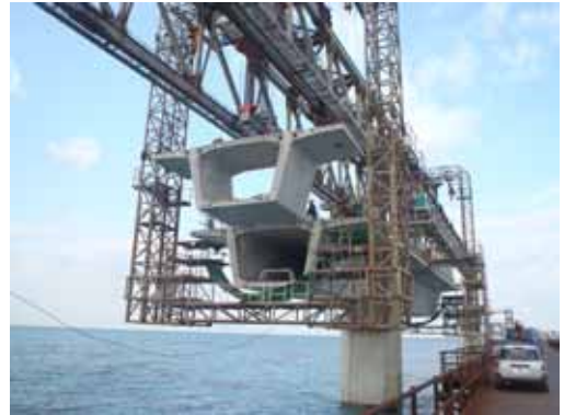
写真-4 セグメント架設状況
