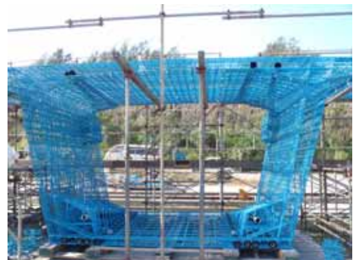
写真-2 エポキシ樹脂塗装鉄筋
