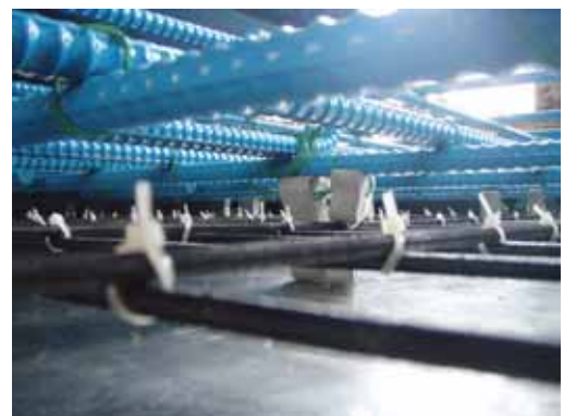
写真-3 CFCC配置状況
