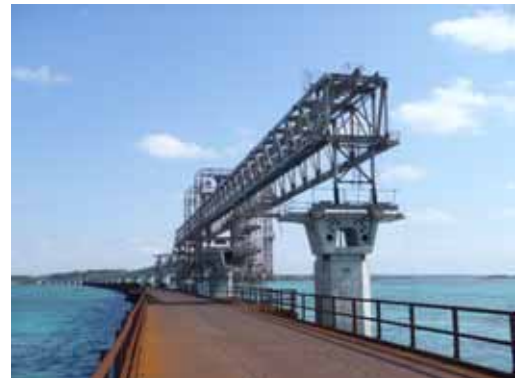
写真-5 上部工全景
