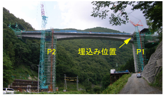
写真-2 橋梁の概観
