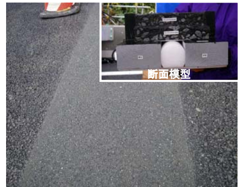
写真-4 埋設ジョイントの設置状況
