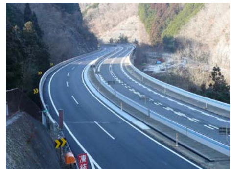
写真-7 完成状況
