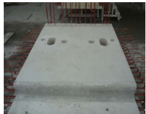
写真-3 地覆の一体製作状況
