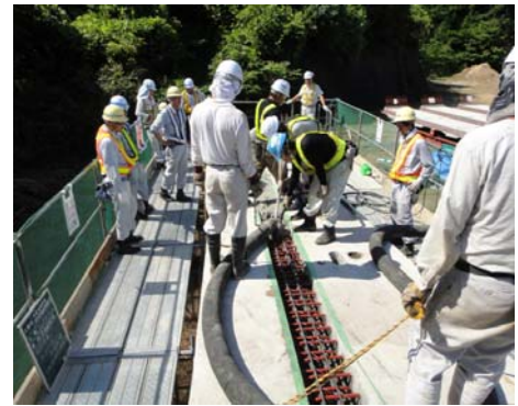
写真-5 ポンプ圧送試験状況
