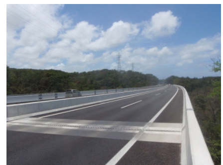
写真-7 完成写真
