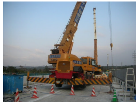
写真-4 地覆壁高欄撤去 (50t吊りラフテレーンクレーン使用)
