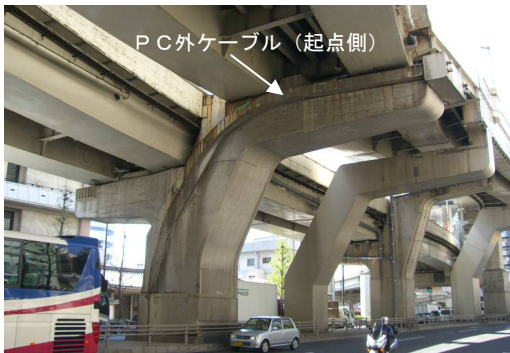
写真-1 PC外ケーブルで補強された橋脚
