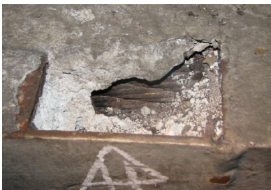
写真-2 点検時の状況
