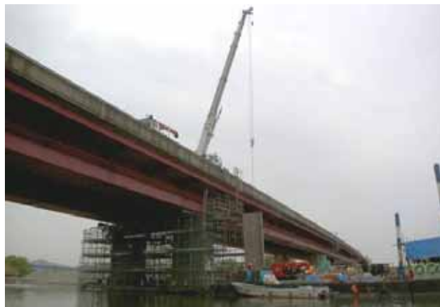
写真-2 PCaパネルの架設状況
