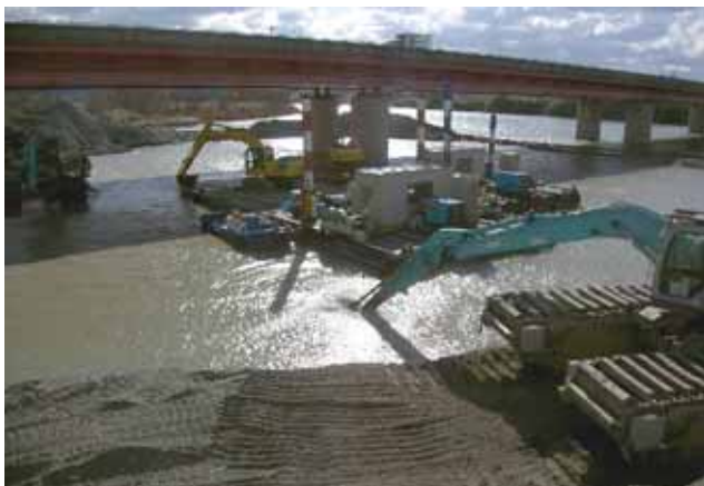
写真-1 河床掘削状況
