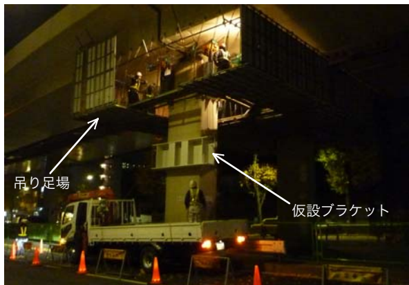
写真-3 仮設ブラケット搬入(夜間規制)
