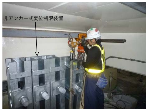
写真-5 施工状況(吊り足場施工)
