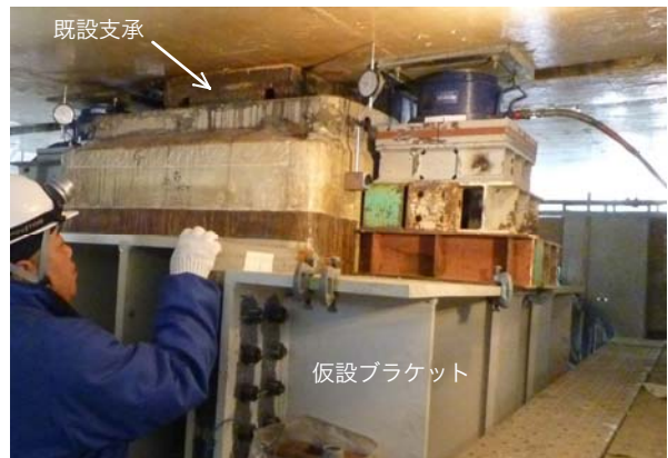
写真-4 ジャッキアップ
