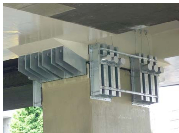
写真-6 施工完了(目-442 橋脚)
